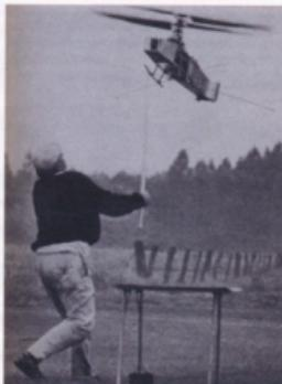
Der Koaxialhubschrauber von Herbert Deu aus Buchtwelmen zeigte, dass die Getriebekonstruktion bestens funktionierte. Ein Sprungstart erfolgte, danach schmierte der Hubschrauber jedoch auch seitlich ab und stürzte ins Gras (Foto: Ferdinand Paul)
